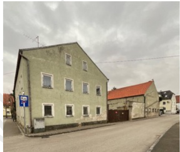
Historischer Hof in schlechtem Zustand
