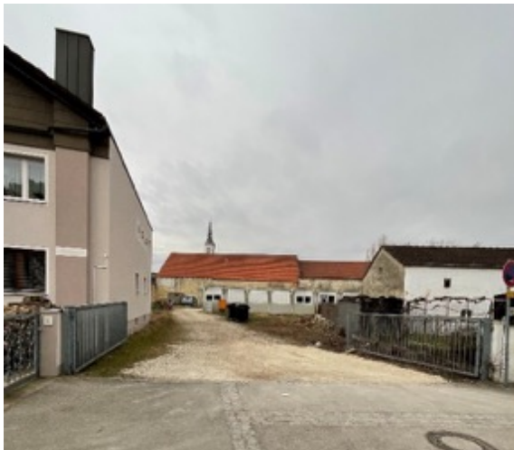
Ungeordneter rückseitiger Bereich mit hoher Anzahl Nebengebäuden
